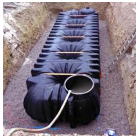
Der GRAF Platin Flachtank wurde mit dem Bagger in die Baugrube versetzt
