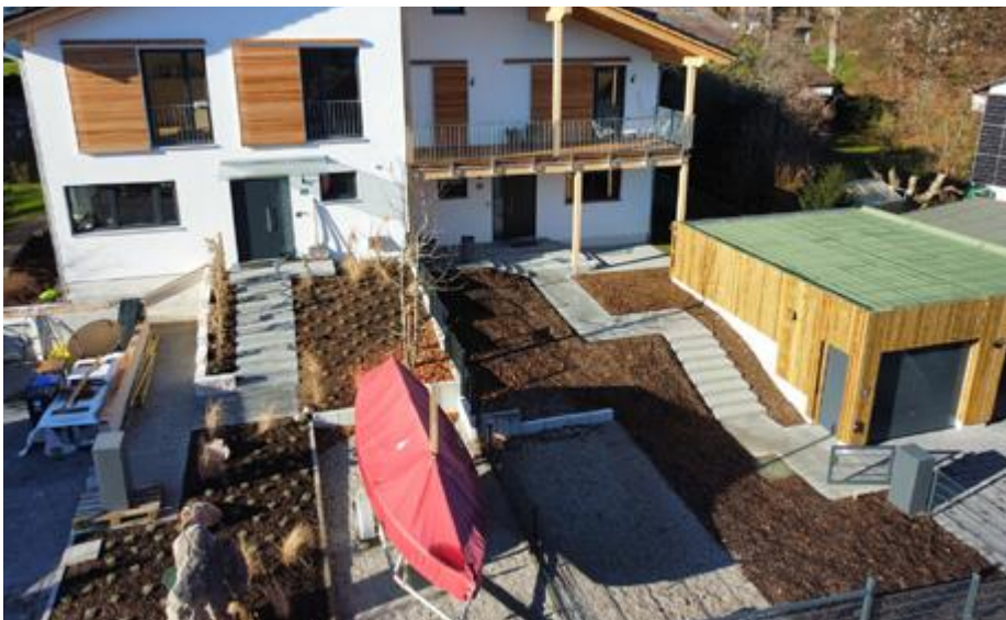
In Pöcking am Starnberger See entstand eine kombinierte Lösung aus Regenwassernutzung und -versickerung von GRAF
