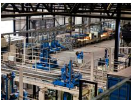
Investition für langfristige Wettbewerbsfähigkeit: REDSUN ersetzt eins von fünf Werken durch eine komplett neue Betonfabrik
