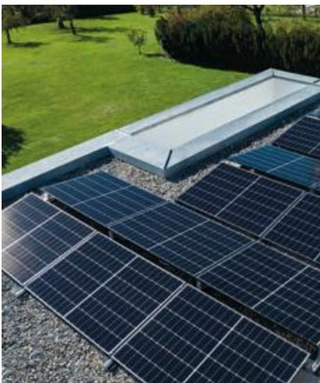
Die bituminöse, faserverstärkte Beschichtung der Flachdachdämmplatte Solarrock trägt solche Anlagen-Lasten zuverlässig ab.
