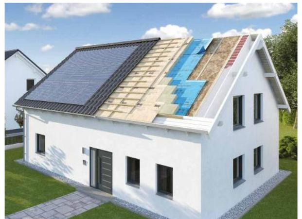
Bei KombiPlan greifen zwei Schichten aus hochwertigen Dämmstoffen effektiv ineinander: emissionsarme, angenehm zu verarbeitende Glaswolle-Zwischensparren-Dämmung und belastbare Steinwolle-Aufsparren-Dämmung. Dazwischen liegt eine plan verlegte Luftdichtheitsschicht für Diffusionsoffenheit.
