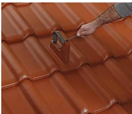
Die integrierte Modulstütze ist aus witterungsbeständigem Aluminium gefertigt, sichert die Übertragung der Lasten in die Unterkonstruktion und bietet Windsogsicherheit.
