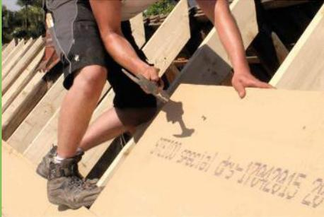
Bei der STEICO Dachsanierung wird das Dach von außen geöffnet. Der Wohnraum unterm Dach bleibt dabei unangetastet. Und weil die Dämmung von außen erfolgt, geht innen kein Wohnraum verloren. Durch die Kombination von flexiblen Dämmplatten und unterschiedlich dicken Unterdeckplatten lässt sich der U-Wert des Daches nach Wunsch erreichen – vom gesetzlichen Mindeststandard bis zum Förderstandard oder Passivhausniveau.
