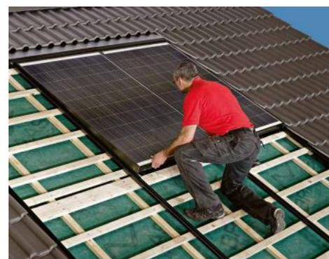
Das BRAAS Indach-System PV Indax ist auf die nahtlose Integration von hochwertigen kristallinen PV-Modulen in Dächer mit den gängigen Dachpfannen ausgelegt. Das System übernimmt die Schutzfunktion der Dachdeckung und produziert umweltfreundlichen Solarstrom – und das als optisch höchst ansprechende Lösung.
