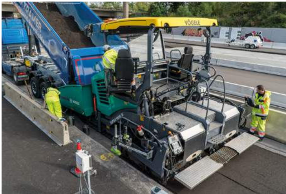
Einbau der Kaltrecyclingschicht auf dem duraBAST
