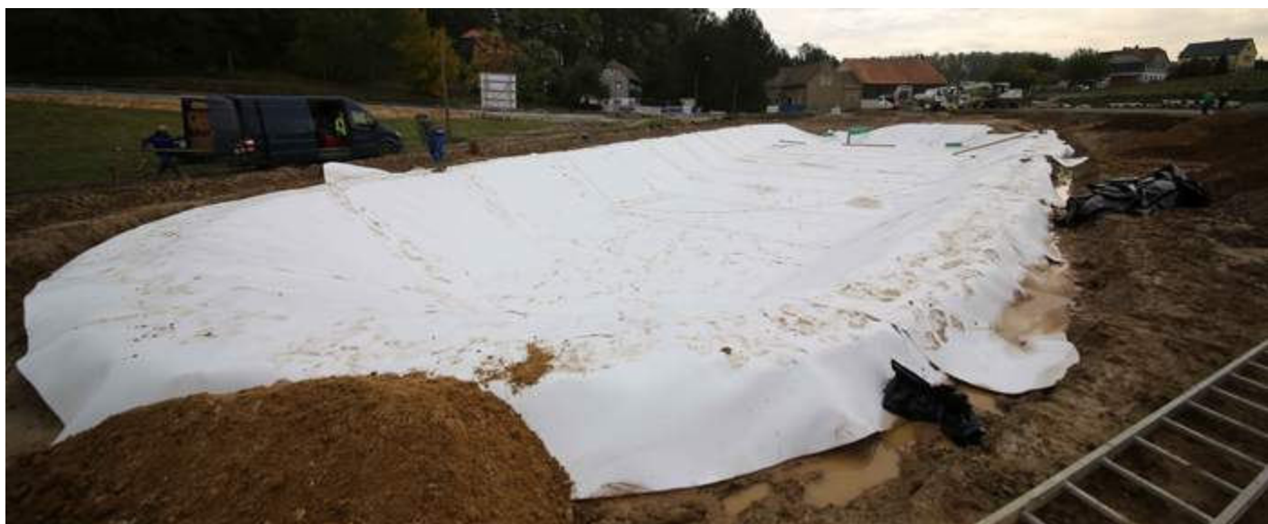
Baustellenansicht mit eingebauter TPD
