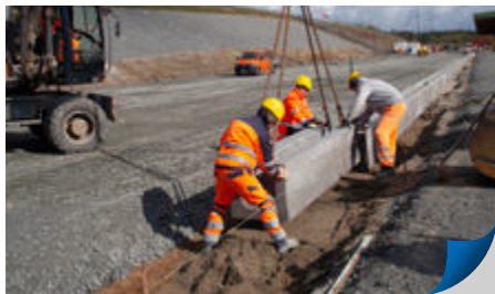
Ruhig und sicher werden die BIRCOmassiv Entwässerungsrinnen von oben verlegt
