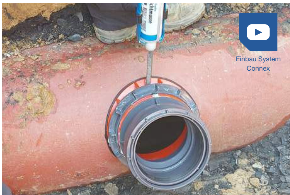
Je nach Witterung ist die Endfestigkeit der dauerelastischen Dichtmasse nach 50 – 70 Minuten erreicht
