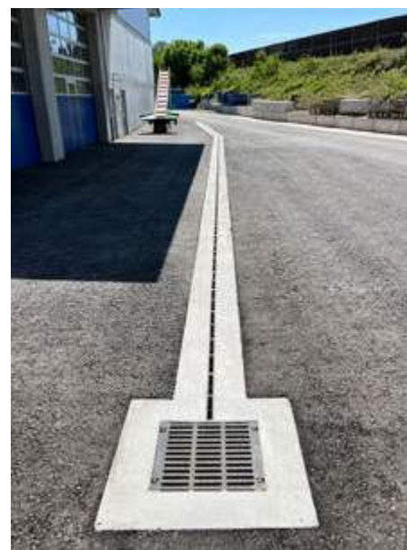
Lange Entwässerungsstränge und unterirdisch verlaufende Rinnenkörpern garantieren eine hohe hydraulische Aufnahmekapazität
