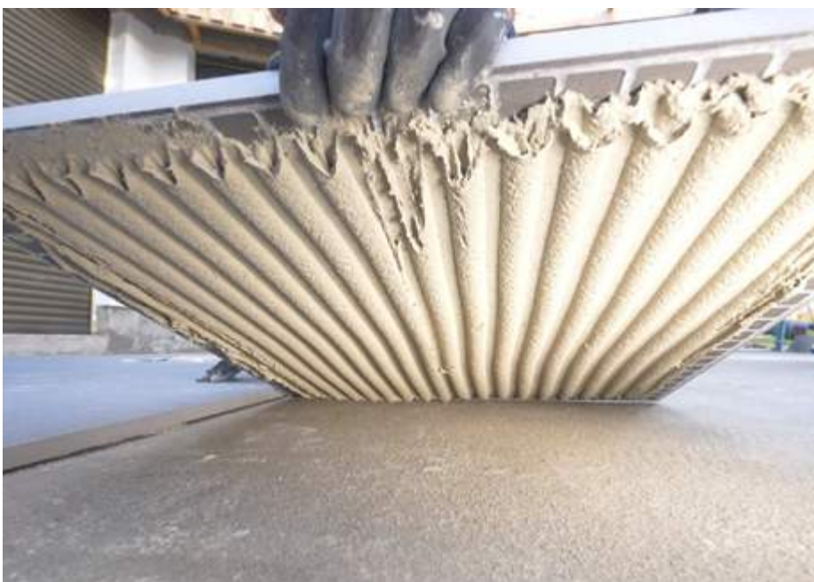
Haftbrücke zur besseren Untergrundhaftung nachfolgender Beschichtungen auf glattem Untergrund
