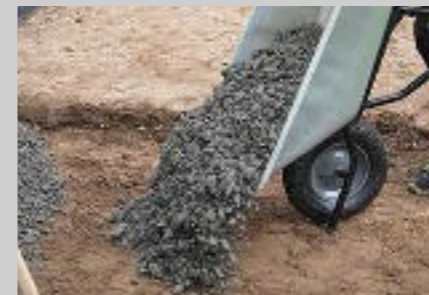
4. Bringe die benötigte Menge an Mineralgemisch ein, und verdichte diese.
