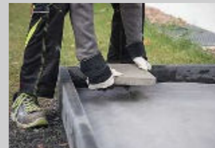
7. Lege als Basis für die Stelzlager in regelmäßigen Abständen Betonplatten auf das Vlies.
