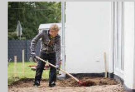
2. Die abgesteckte Fläche kann nun ausgeschachtet werden.
