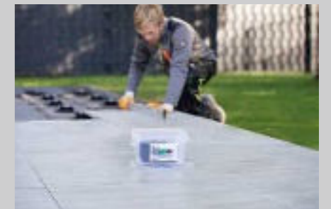
9. Jetzt kannst Du die Terrassenplatten verlegen.
