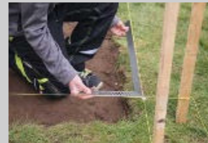
1. Beginne mit dem Einmessen und Abstecken der Terrassenfläche.
